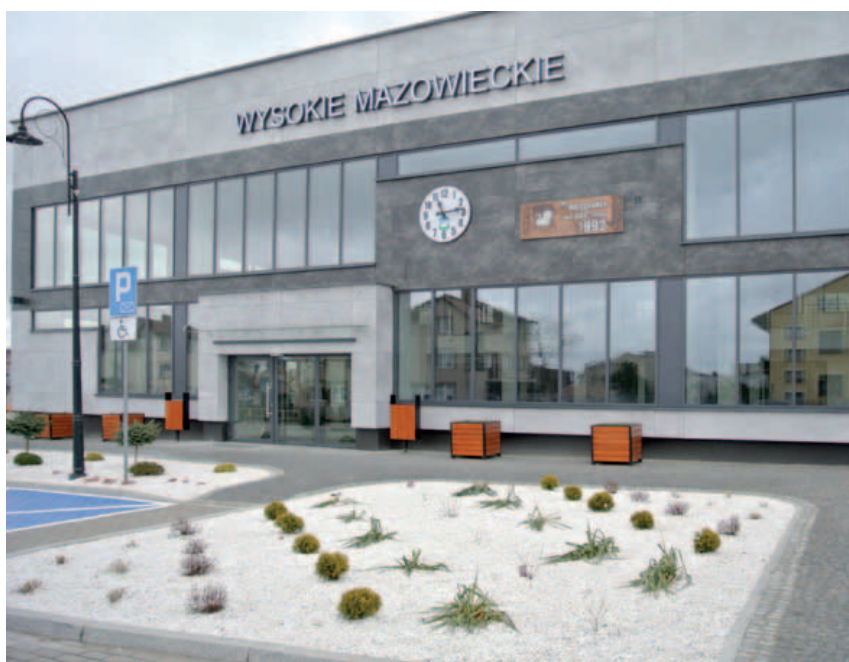
▲ Wyremontowany dworzec w Wysokim Mazowieckiem. Fot UM Wysokie Mazowieckie
