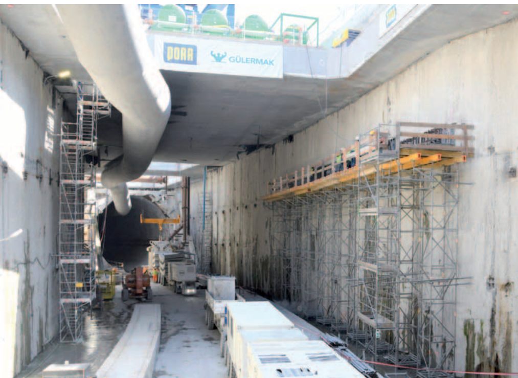
▲ Budowa tunelu pod Świną. Fot UM Świnoujście
