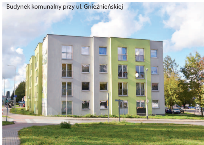
Budynek komunalny przy ul. Gnieźnieńskiej
