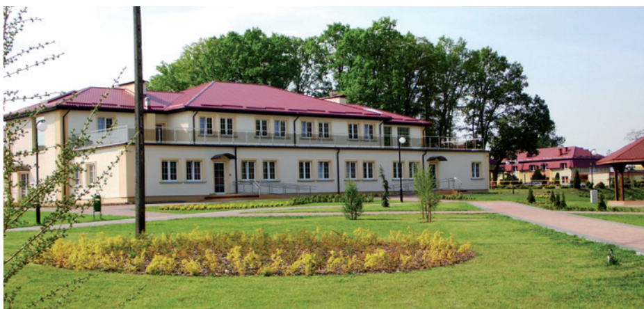
▲ DPS – pawilon mieszkalno-rehabilitacyjny
